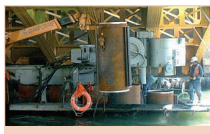
上部障害クリア工法 (鋼管矢板)
