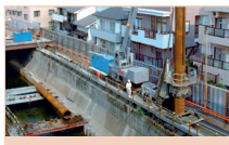
鋼管矢板圧入工法
