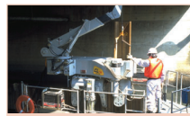
上部障害クリア工法
