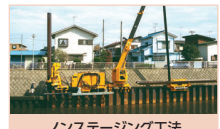
ノンステージング工法 (GRBシステム)
