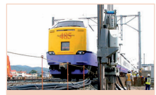
ゼロクリアランス工法 (硬質地盤対応)
