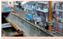
鋼管矢板圧入工法
