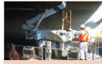
上部障害クリア工法
