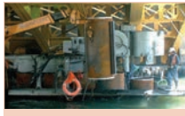
上部障害クリア工法(鋼管矢板)
