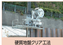
硬 質 地 盤 ク リ ア 工 法
