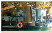
上 部 障 害 ク リ ア 工 法 (鋼 管 矢 板)
