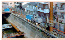
鋼 管 矢 板 圧 入 工 法
