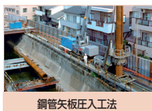
鋼管矢板圧入工法
