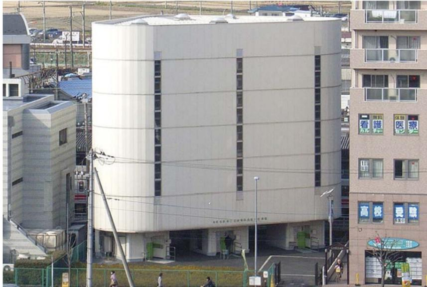
海老名駅前の相鉄線沿いにある約430㎡の限られたスペースに、地上式で720台という高収容化を実現した。4基のエコサイクルと管理室を効率良く配置し、スムーズな利用者動線を確保している。
