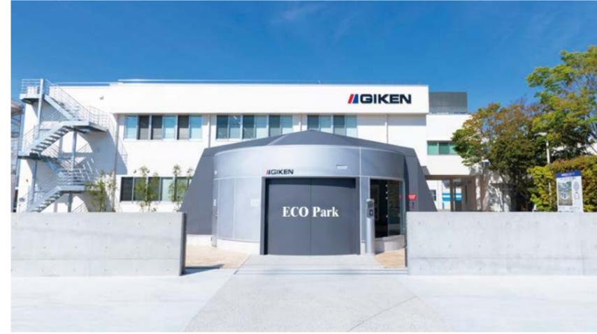
1994年に完成したエコパーク1号機から24年が経ち、当時から車市場も様変わりした。ハイルーフ車やワイド車にも対応するためにリニューアルを行った。阪神・淡路大震災で震度4、芸予地震で震度5の揺れを経験しても、変位・損傷なく、インプラント構造<sup>®</sup>の強靭さを実証した以前の地下躯体はそのまま活用し、機械装置・システムをリニューアルした。最新の機械システムを導入することで、平均出庫待ち時間を38秒から29秒まで大幅に短縮した。
