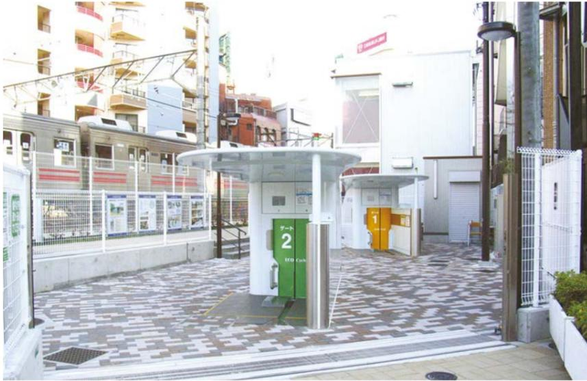
東急東横線と大井町線が交差する自由が丘で、幅11mの狭隘かつ鉄道近接という条件下での設置工事。多くの制約条件にも拘らず、システム化された専用機による圧入工法で、隣接する鉄道や建物に影響を与えることなく、短工期・コンパクト施工を実現した。
