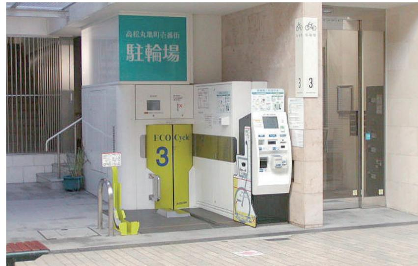
香川県高松市丸亀町再開発の一環として、商店街に建設された商業施設とマンションの複合ビル内にエコサイクル3基を設置。入出庫ブースは建物と一体化したデザインで、マンション居住者と買い物客の定期および一時利用として運用されている。
