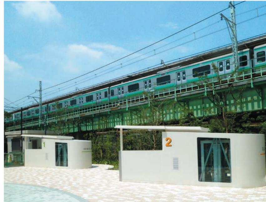
三河島駅前南地区の再開発事業にて、荒川区の公共駐輪場としてエコサイクル2基を導入。荒川・江戸川などの河川によって形成された沖積低地であるうえに、JR線に近接した場所での施工事例。周囲に影響を与えず、再開発ビル建設と調整を図りながら、省スペース・短工期施工を実現。駅の改札にも近く、利便性の高い駐輪場が完成。
