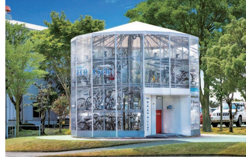
社員駐輪場兼プロモーション用として2012年8月に1基目、2019年3月には新社屋の増築に伴い2基目を設置。7年の間、何度も台風が上陸したが問題なく稼働している。それぞれ認証方式が暗証番号方式、ICカード方式となっており、見学者は両方を体験することができる。また、2基目は本社見学ルートの一つになっており、隣接するエコパーク(P25参照)と共に地下開発製品を体感することができる。
