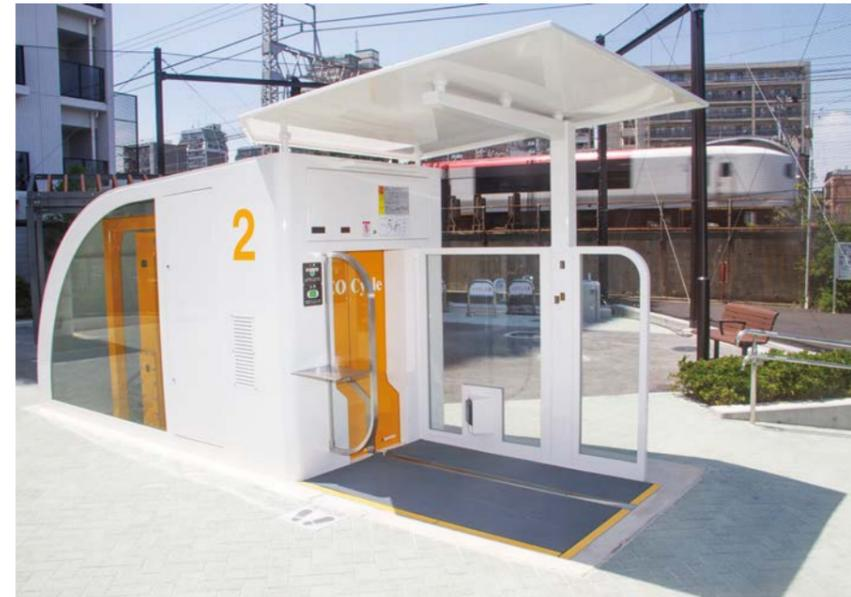
民間開発事業で整備された、新小岩二丁目小松菜児童遊園内にエコサイクル2基を導入。地下機械式駐輪場の導入により、用地確保が難しい駅周辺の駐輪場不足の解消に寄与。建築工事との並行作業および鉄道近接、狭隘地施工など複数の過酷な制約条件の下、省スペース施工を実現。葛飾区では初の導入事例となる。
