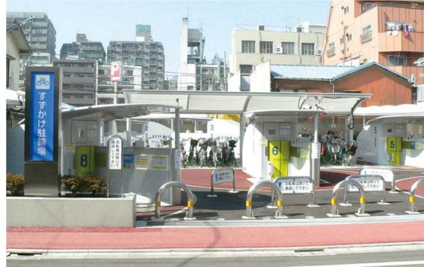
三鷹駅南口から徒歩5分。閑静な住宅地にある664㎡の敷地に、エコサイクル8基を機能的に配置し、地下に1440台の自転車を収容する。周辺の住環境に影響を与えず、従前の平置き時に比べ3倍の収容能力を確保した。
