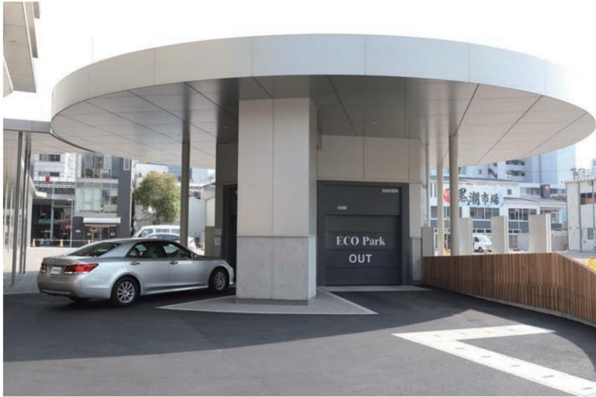
高知県と高知市が共同で整備した、新図書館等複合施設「オーテピア」へエコパーク1基を設置。公共施設へのエコパーク初納入となった。標準仕様よりも10台多い、60台を収容できる特別仕様となっている。地下躯体は鋼管杭を円形に施工して構成されており、地震に粘り強く耐えることができる。また、入出庫ブースには広いガラス面が設けられており、自動車が地下に搬送される様子を見物する利用者も多い。『地上に文化を、地下に機能を』のコンセプトのもと、当社の圧入技術で構築する円筒形の地下空間に車両を収容することで、地上にゆとりある空間を創出している。
