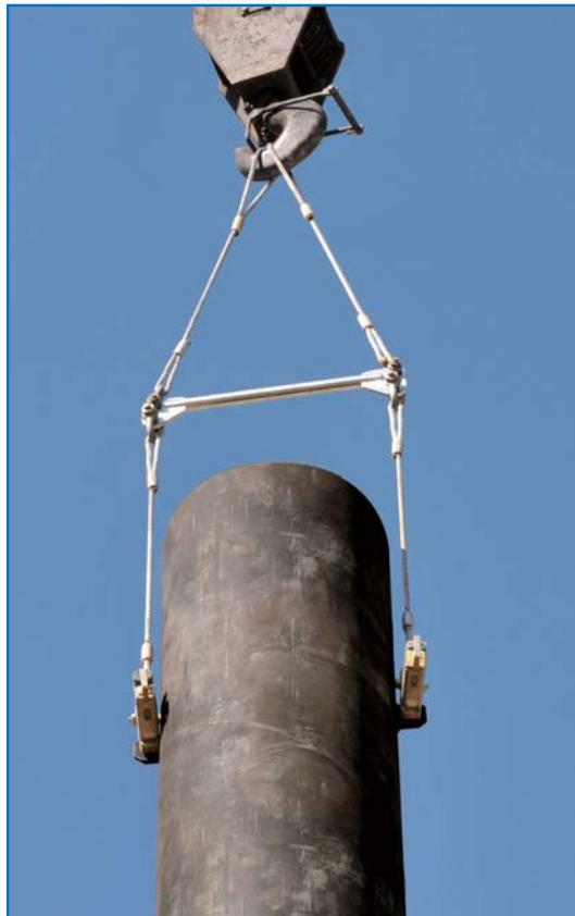
吊りワイヤーのキンク・磨耗・損傷を防ぎ、吊り作業の安全化、効率化を図ります。スプレッダービームの構成は軽量、コンパクトであり、1種類のスプレッダービームで2~4種類の钢管径に対応できます。
