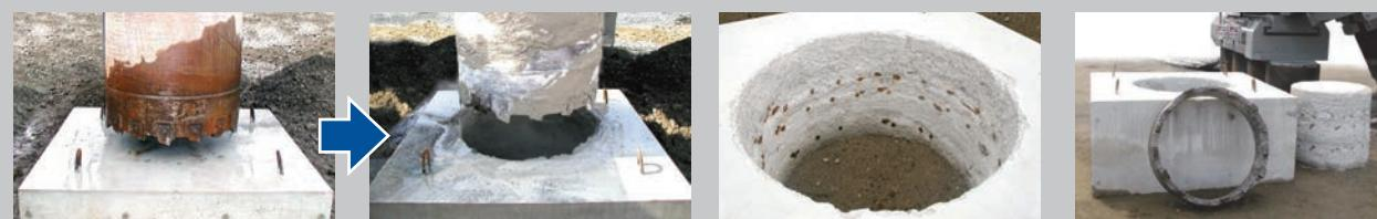
鉄筋コンクリート(厚さ80cm, σck=24N/mm<sup>2</sup>, D16@250×3段)を、回転切削圧入により鉄筋を切断して貫通させた状況。
