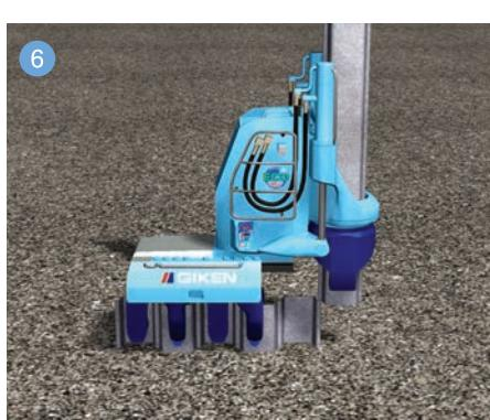
反力架台を撤去し、初期圧入完了
