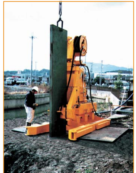
写真は、コンクリート矢板KC150～KC350（1000ピッチ）施工時のものです。
