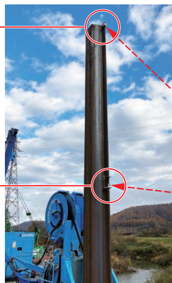
施工中の鋼矢板
