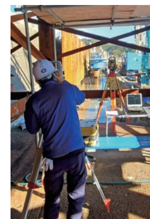
② トランシットによる 変位測定
