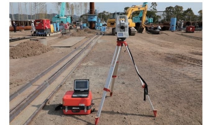
① トータルステーション設置
