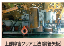
上 部 障 害 ク リ ア 工 法 (鋼 管 矢 板)
