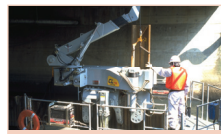
上 部 障 害 ク リ ア 工 法
