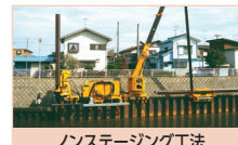
ノ ン ス テ ー ジ ン グ 工 法 (GRB シ ス テ ム)
