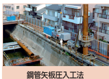
鋼 管 矢 板 圧 入 工 法
