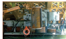
上部障害クリア工法(鋼管矢板)
