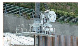
硬質地盤クリア工法
