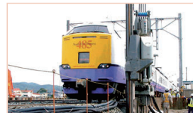
ゼロクリアランス工法(硬質地盤対応)
