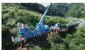
スキップロック工法™ (スキップロックアタッチメント使用)
