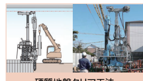
硬質地盤クリア工法 (ハンドリングシステム使用)
