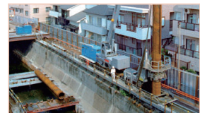
鋼管矢板圧入工法
