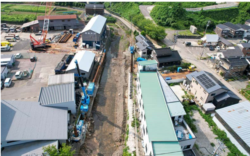
提供：令和 6 年奥能登豪雨塚田川災害復旧その 1 工事 熊谷組・石田工業地域維持型建設共同企業体
