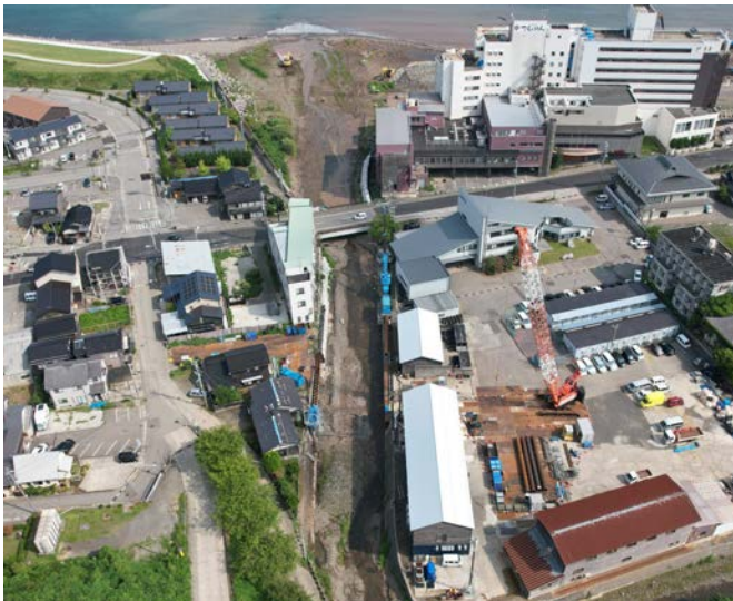
提供：令和 6 年奥能登豪雨塚田川災害復旧その 1 工事 熊谷組・石田工業地域維持型建設共同企業体
