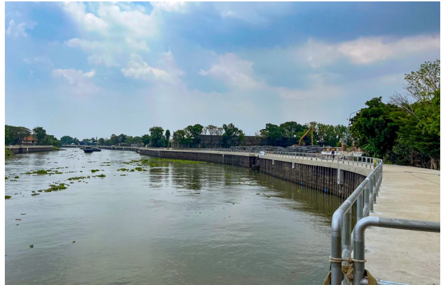
フェーズ2の一工区で完成した護岸
