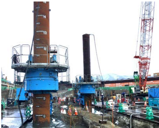
2017 年から 2 工区にわたり行われた水門基礎工事の様子
