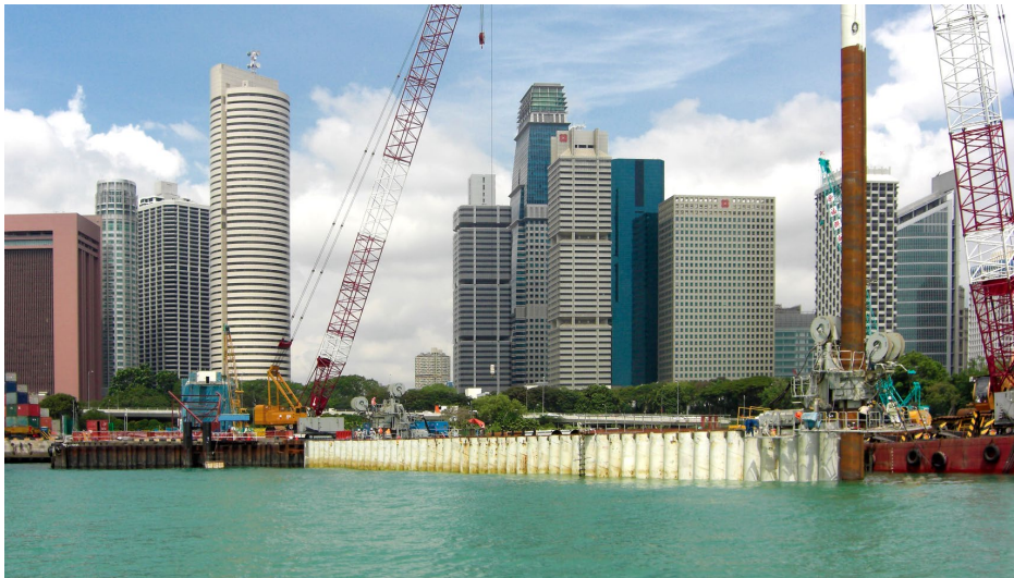
シンガポールでの高速道路建設工事（2010 年）
