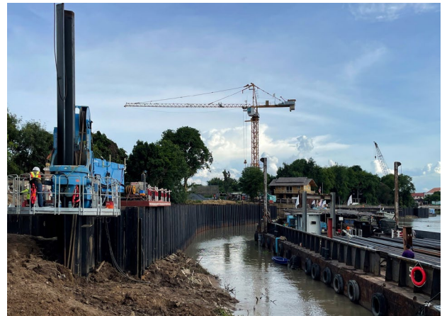
タイの河川護岸整備工事（2022年）
