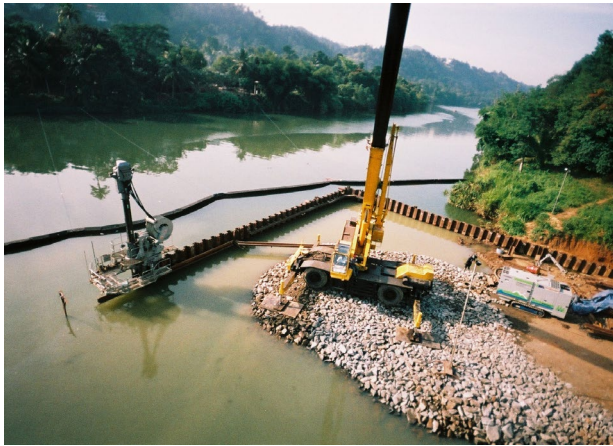
スリランカの上水道取水施設工事（2004年）
