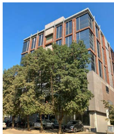
技研製作所 アーメダバード事務所のあるオフィスビル
