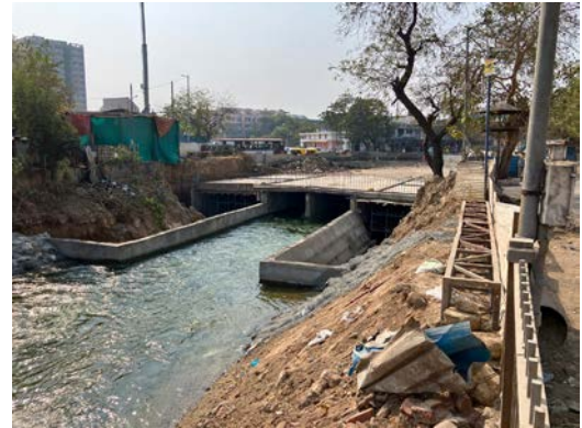
工事区間の現状（一部）
