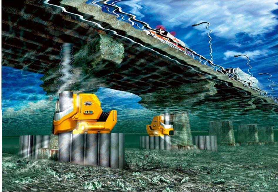
水中パイラーの施工イメージ
