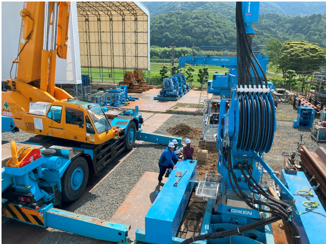
関西工場にある実習フィールド
