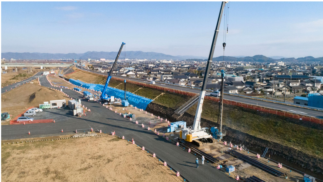
ハット形鋼矢板（900 mm幅）の硬質地盤圧入による河川堤防の補強工事
