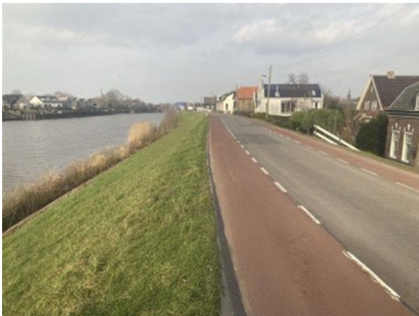
脇に住宅が立ち並ぶ河川堤防
