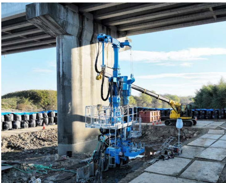
「ハンドリングシステム」を用いた橋梁下の工事の様子
