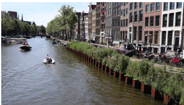
パイロット施工前
