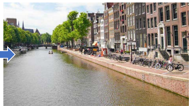
パイロット施工後
