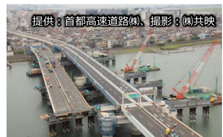
提供：首都高速道路(株)、撮影：(株)共映 高速大師橋の橋桁一括架け替え工事の様子
