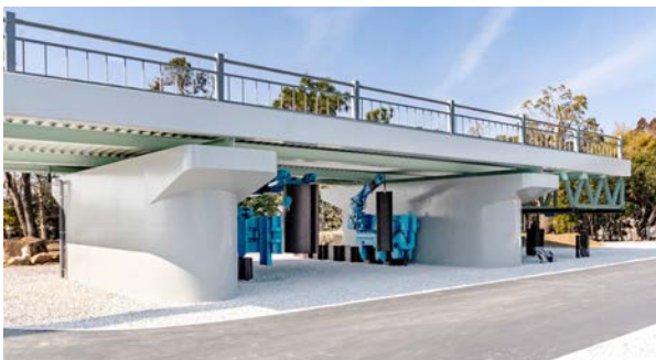
上部障害クリア工法
