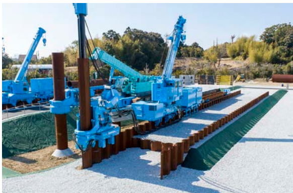
「インプラントロック堤防 ® 」を実寸で再現
