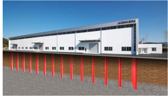
鋼管杭を基礎にした高知第三工場
