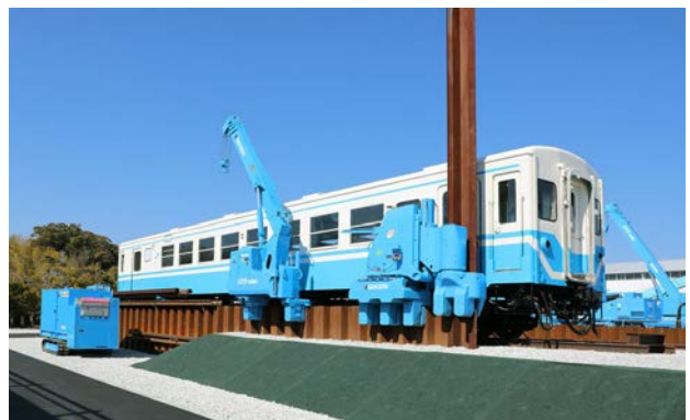
鉄道近接施工
