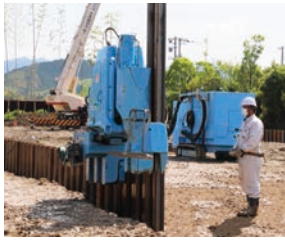
①鋼矢板圧入
