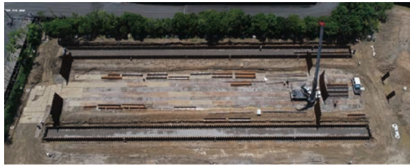
②圧入完了後
