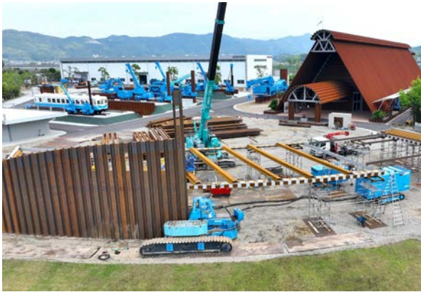
①鋼矢板圧入
