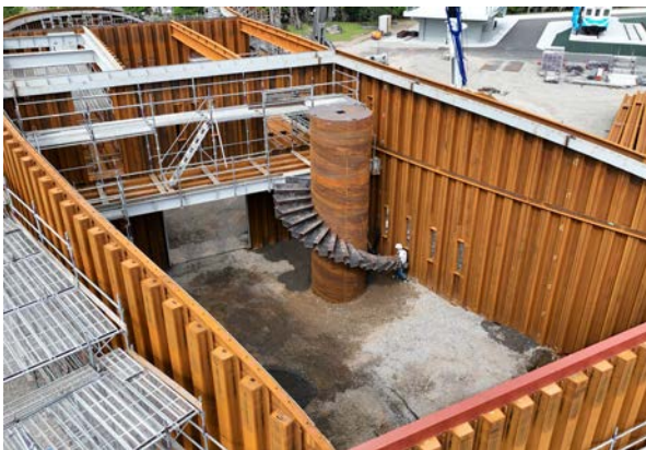
③エレベーター用鋼管杭と螺旋階段を設置
