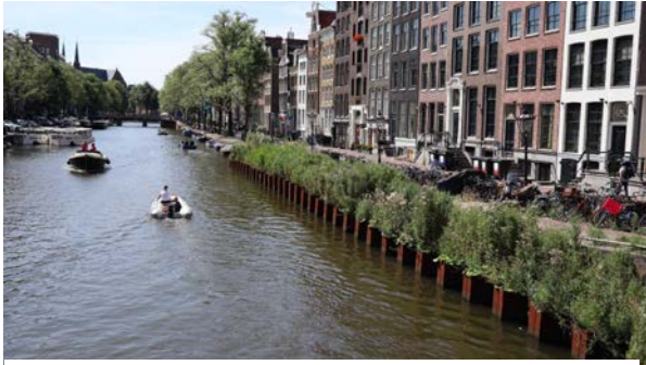
▲着工前の施工場所 (右手前はアムステルダム市が施工した護岸の応急処置での既設鋼矢板)
