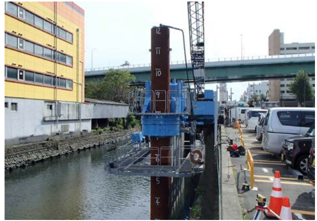
愛知県名古屋市での河川改修工事
