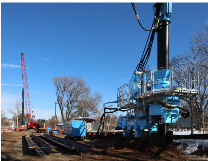
施工中の様子
