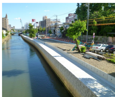
完成後の護岸
