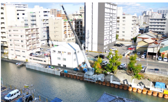
「GRBシステム」を活かした化粧板の設置
