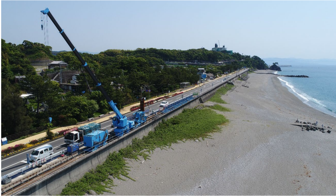
高知市長浜海岸堤防改良工事の様子
