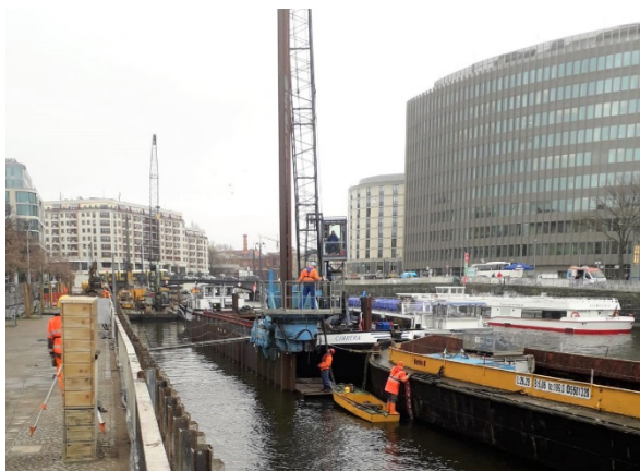
ドイツ・ベルリンでの護岸改修工事
