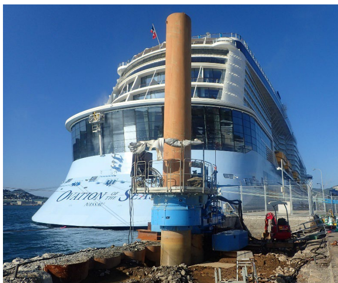
長崎港での岸壁改良工事（平成 29 年 9 月～平成 30 年 3 月） 本 ODA 案件と同様に「ジャイロプレス工法」により鋼管杭と小口径鋼管を圧入し、 岸壁の改良工事を行った。
