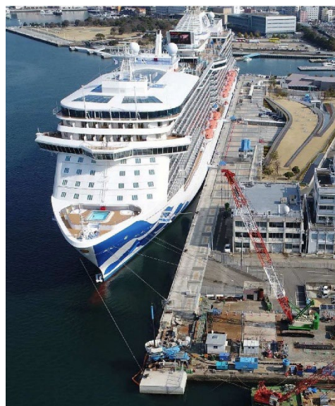
長崎港での岸壁改良工事（平成 29 年 9 月～平成 30 年 3 月） 本 ODA 案件と同様に「ジャイロプレス工法」により鋼管杭と小口径鋼管を圧入し、 岸壁の改良工事を行った。
