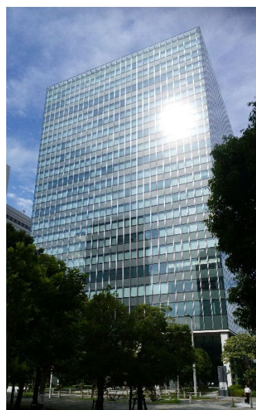
有明セントラルタワー
