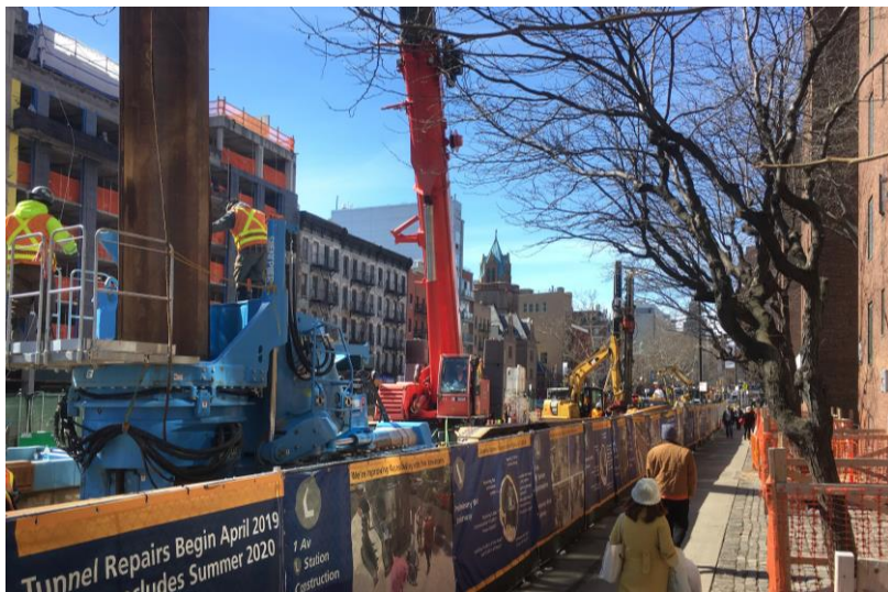
工事中の状況
