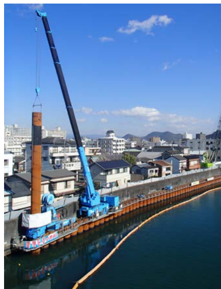
鋼管矢板圧入工法による 高潮対策工事
