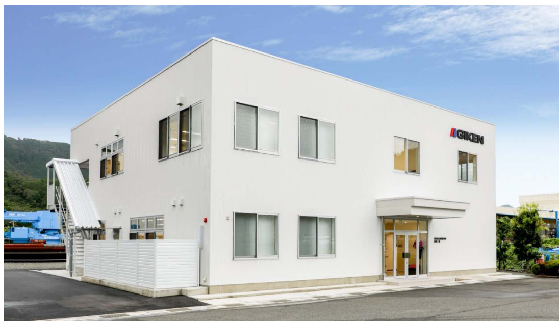
新設した研修棟
