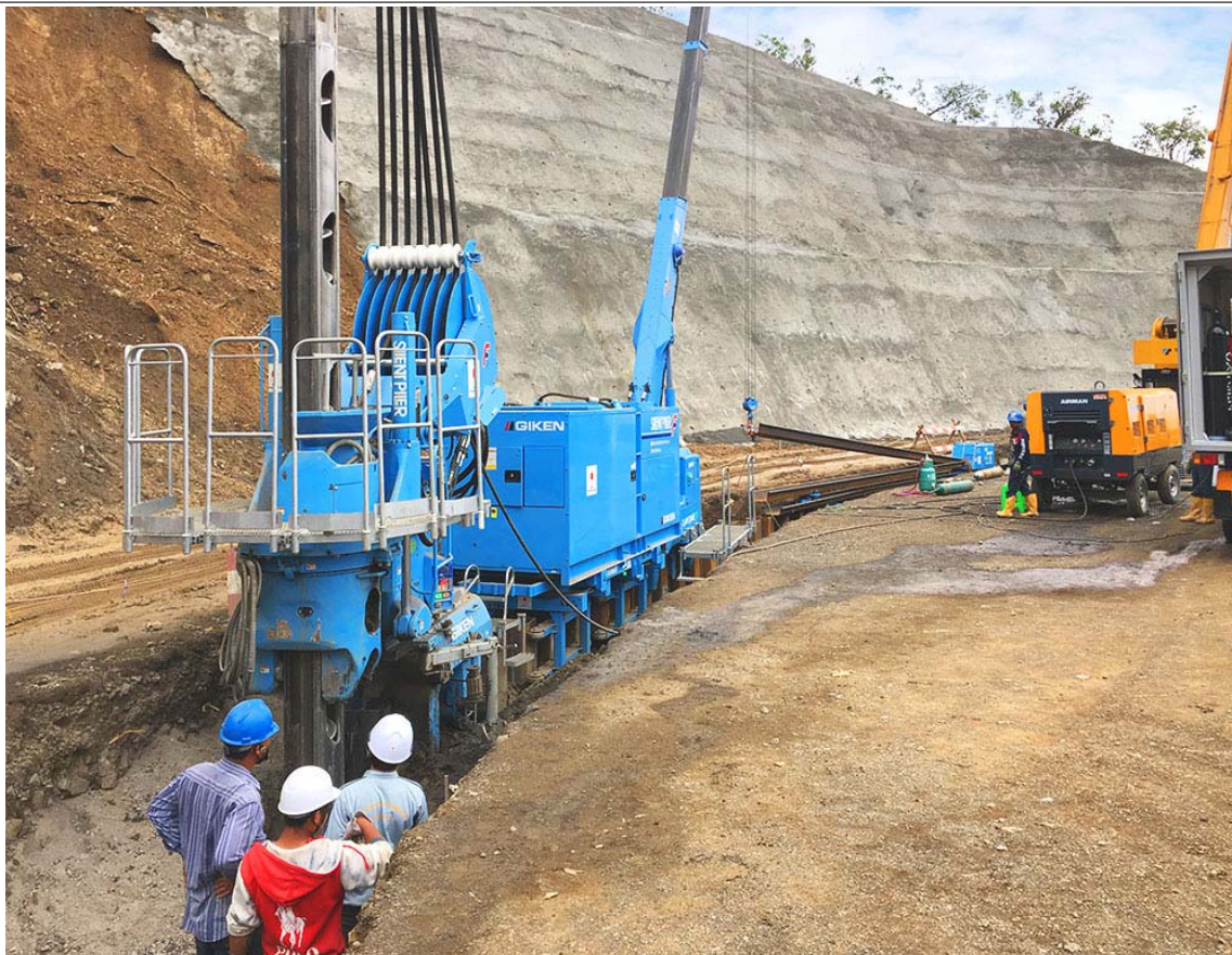
ミャンマー建設省のエンジニアによる施工の様子
