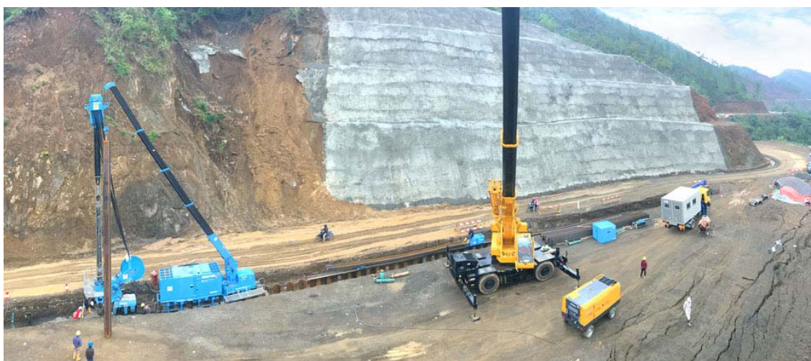
生活道路を確保しつつ補強工事を遂行
