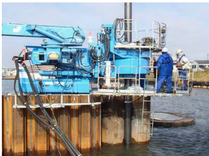
ジャイロプレス工法による止水壁構築の状況
