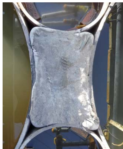
小口径鋼管とモルタルにより 閉止された杭間
