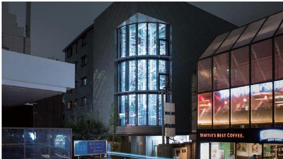
港区営住宅シティハイツ六本木の建替えにあわせ、建物に組込む型で地上式のエコサイクル2基を設置。外装の一部をガラス張りとし、夜間にライトアップを施すことで、収納自転車や機械装置の動きを「魅せる」駐輪場として、街をより魅力的に変えるランドマーク的な存在としても機能する。近隣の三河台公園自転車駐車場と連携した相互利用が可能であり、一方で登録を行うことで双方の駐輪場を利用できる、利便性の高い駐輪環境を実現。港区では4件目の実績となる。
