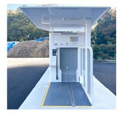
東急新横浜線の新駅「新綱島駅」の整備を契 機としたまちづくりの一環として、エコサイ クル2基を設置。新駅と近接した設置場所にお いて「圧入工法」により周辺環境に影響を与 えることなく施工。施工面のほか、エコサイ クルの安全性やメンテナンス性も高く評価さ れ採用に至った。横浜市では初の地下機械式 駐輪場の導入となる。
