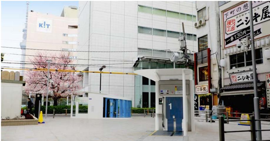
錦糸町駅周辺の繁華街に放置自転車対策としてエコサイクル2基を設置。周囲には飲食店、ホテル、マンションが隣接しており、施工ヤードは約330m<sup>2</sup>と狭隘であったが、コンパクトな施工機械と当社独自の「圧入工法」で周囲への影響を最小限に抑え、施工を実現した。当エコサイクルは収容台数を標準仕様より24台増加の228台とする新仕様を導入している。地上部分のコンパクトな出入庫ブースは周囲の景観を損ねることなく、夜間にライトアップを施すことで「魅せる」駐輪場として街の新たなランドマークとなっている。
