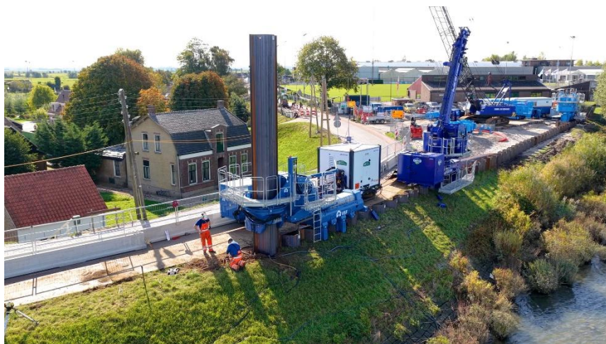
デルタプログラム（カイクPJ）での圧入施工状況
