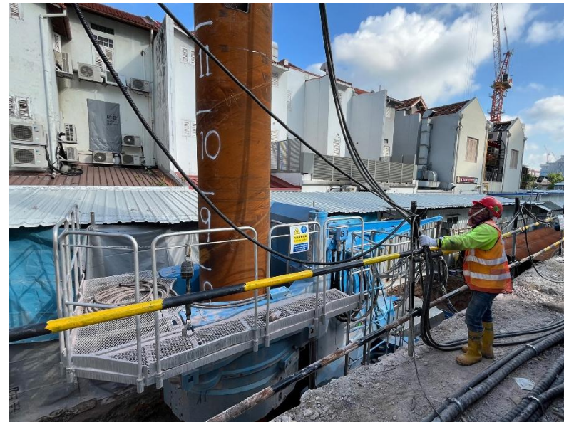
ジャイロプレス工法が採用されたホテル建設に伴う土留め工事
