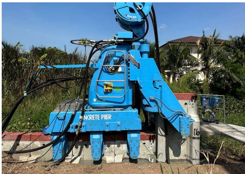
コンクリート矢板試験施工の様子
