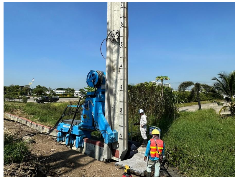
コンクリート矢板試験施工の様子
