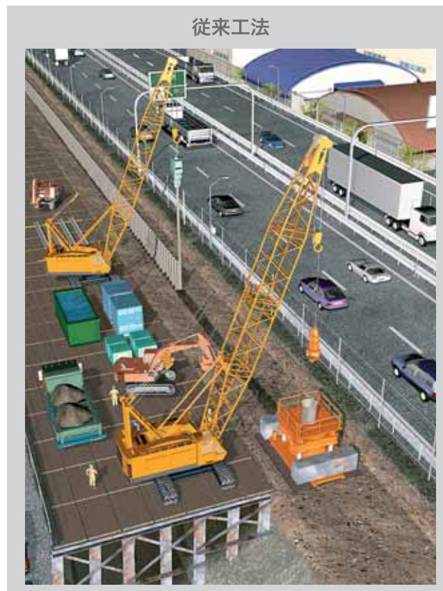
玉石混り層(100・300mm)への圧入
