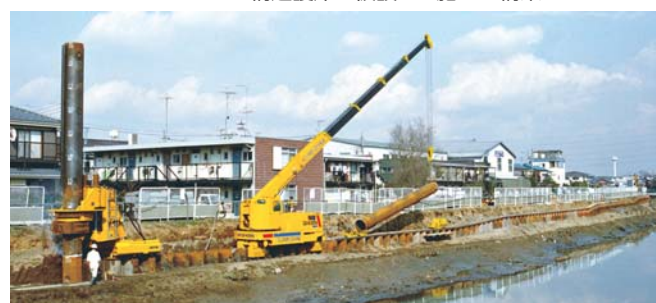
インプラント構造護岸を仮設レス施工で構築
