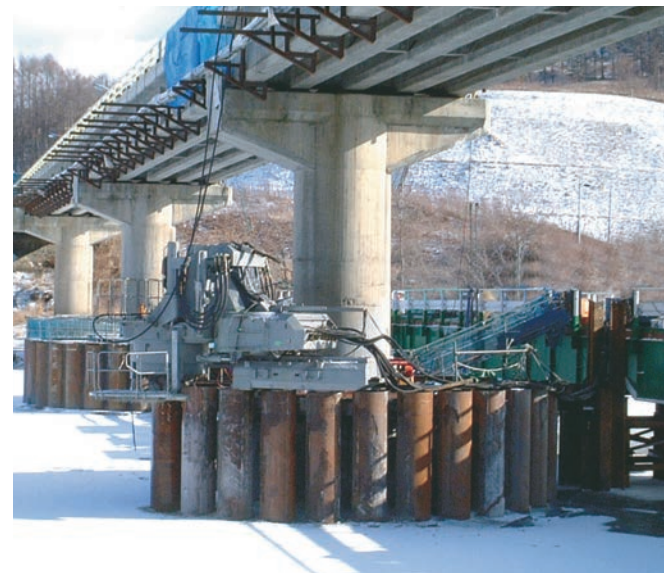
災害復旧橋脚補強（北海道平取町沙流川平取橋）
