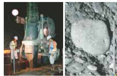
玉石混り層(100・300mm)への圧入
