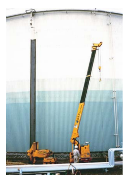
鋼矢板リング工法についてはP17で説明
