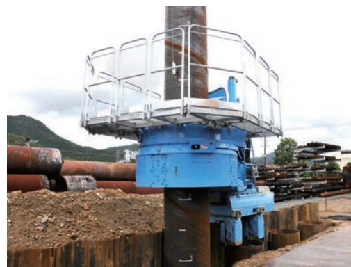
鋼管杭施工状況
