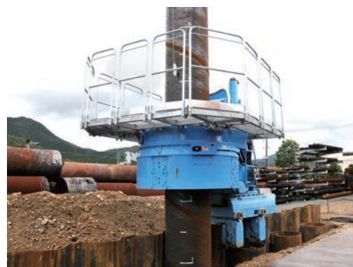
鋼管杭施工状況
