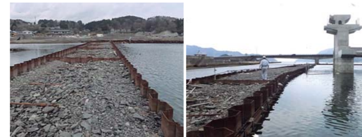
▲ 岩手県下閉伊郡山田町織笠川水門
