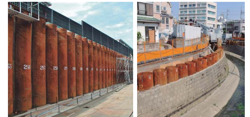
▲ インプラント構造による道路擁壁と河川護岸の補強
