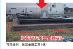
浄水場や下水処理場などの沈砂池を鋼矢板で囲い込み、液状化による不同沈下を抑制します。東日本大震災でも、拘束地盤免震を施した沈砂池に変状は発生しませんでした。
