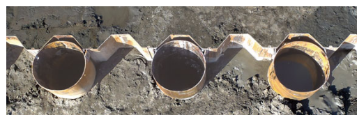
壁体の断面形状
