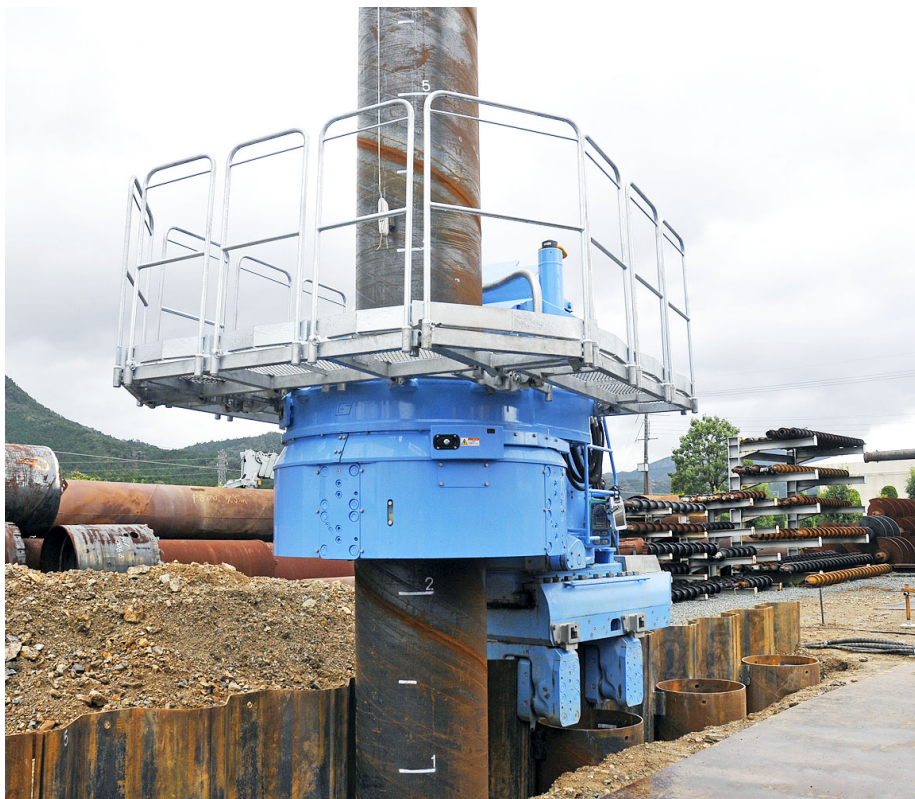
技研製作所／関西工場での実証試験（2013年10月実施）
