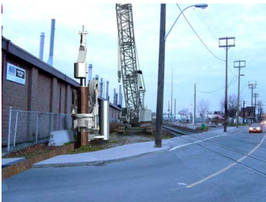
施工イメージ
